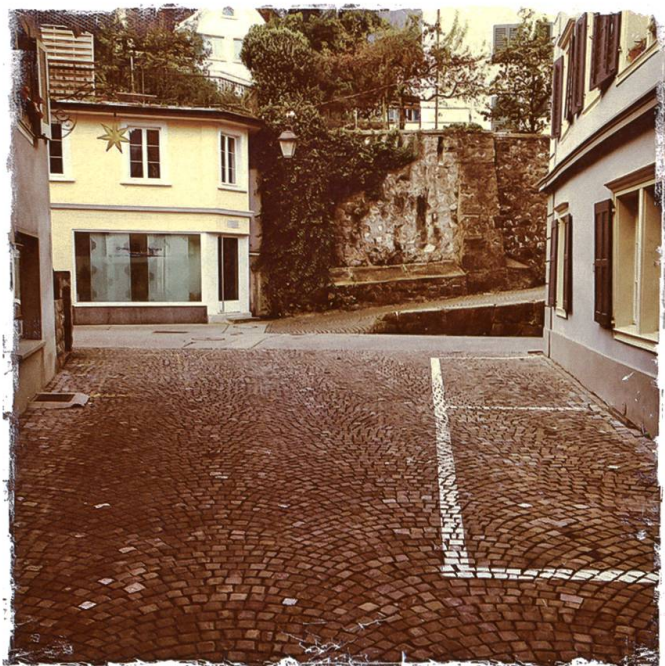
Die Hanglage von Stans macht sich mit Stützmauern bemerkbar. Die räumlichen Verbindungen zwischen dem oberen und dem unteren Niveau sind einzigartig.
