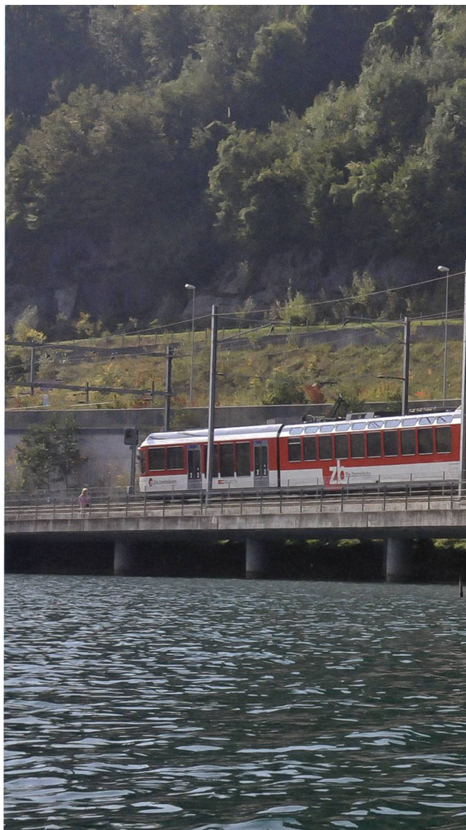
Hauptverkehrsader: Die Zentralbahn, hier bei Horw, ...
