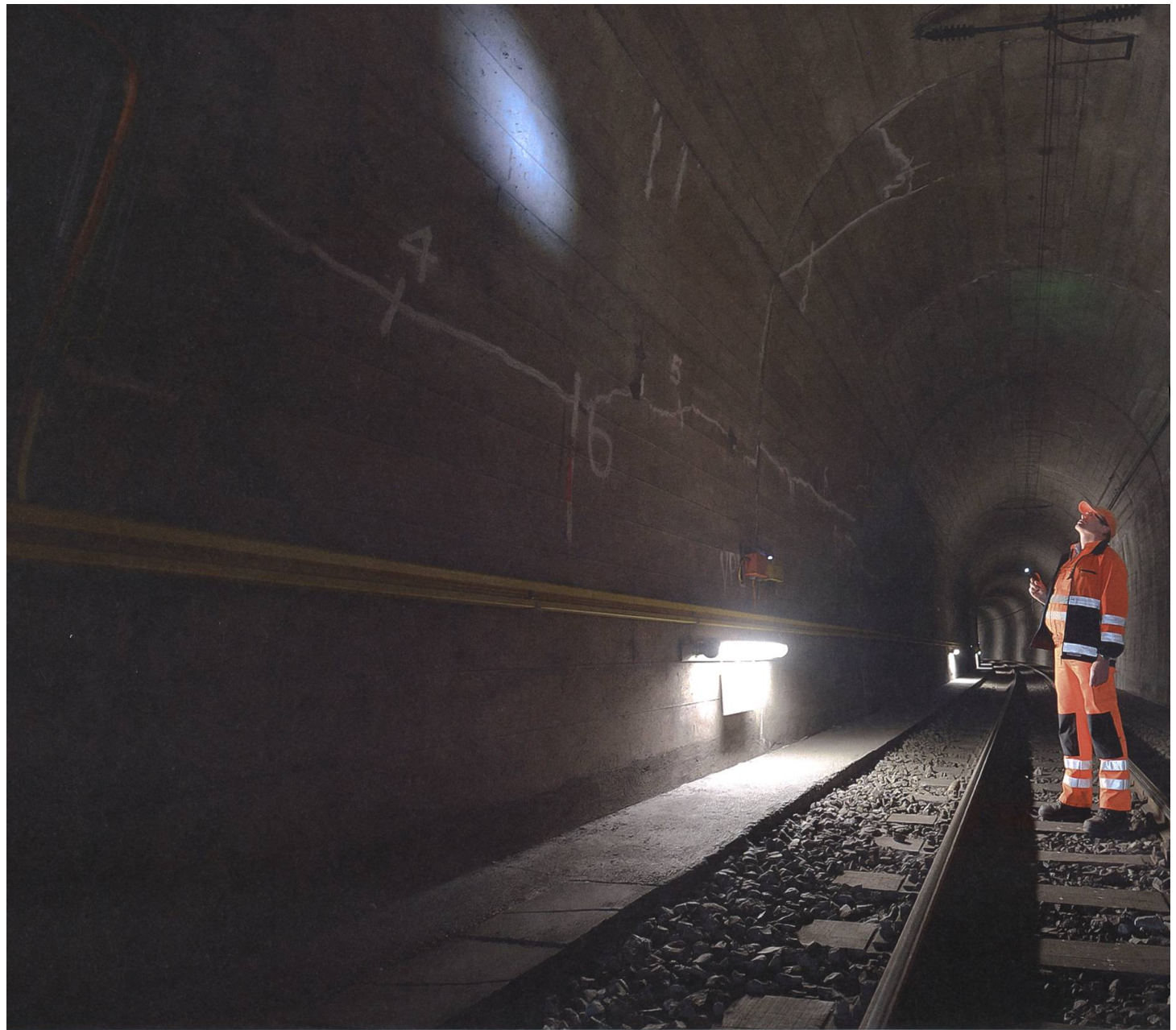
Röhren-Check: Armin Mathis kontrolliert im Loppertunnel auch den Zustand der Gewölbemauern.
