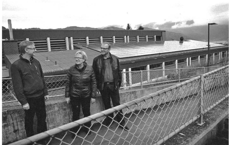
18.10. Schule Buochs: Sporthallendach mit Solarzellen.
