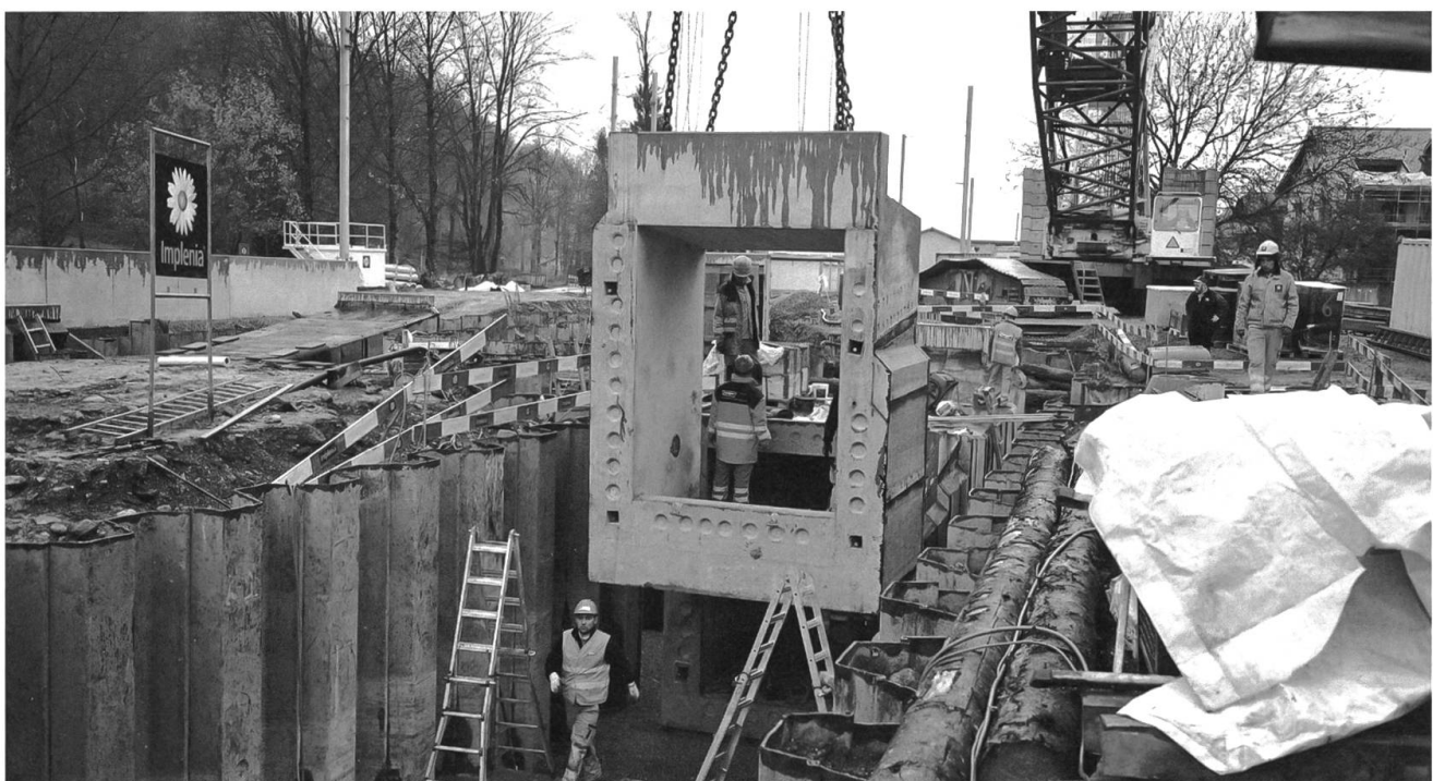
22.11. Hier entsteht der neue Bahnhof Wolfenschiessen.
