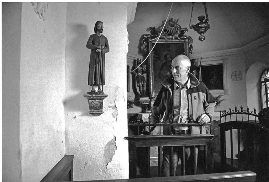
11.10. Kapelle St. Heinrich: Die Schäden sind unübersehbar.
