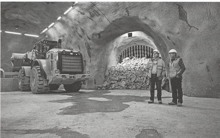
23.10. Das neue Untertagebauwerk im Steinbruch Kehrsiten.
