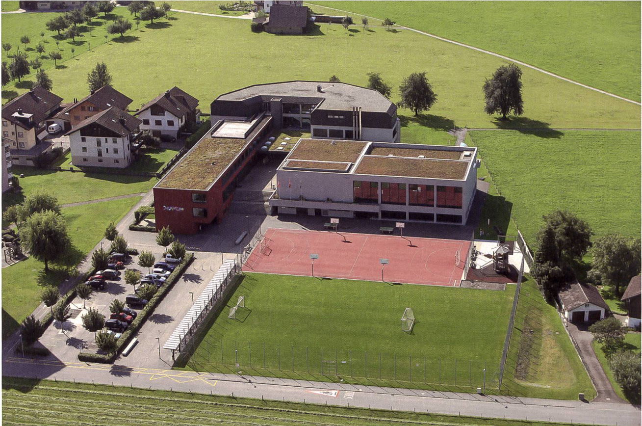
Anschluss 1: Die Schule Oberdorf gab den Anstoss zur Planung für den weiteren Ausbau des Wärmeverbundes in Oberdorf.
