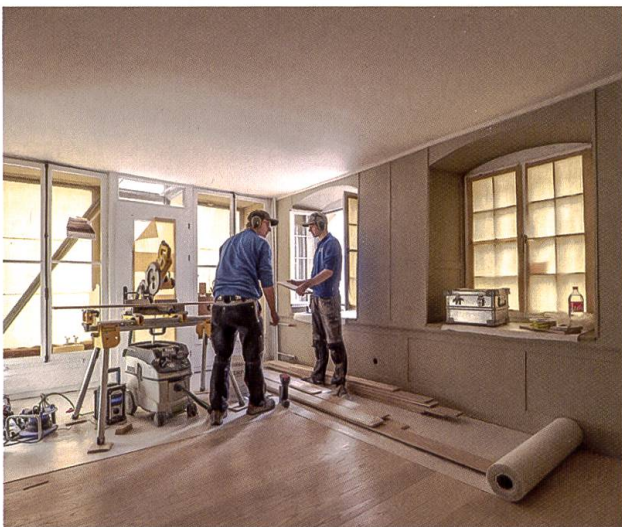
Stefan Flury legt in der grossen Fertigungshalle selber Hand an - Mitarbeiter Roman Achermann beim Abrichten in der Schreinerei - Peter Wagner und Roman Achermann verlegen einen Mondholzboden im Stanser Geschäftslokal Teegarten.
