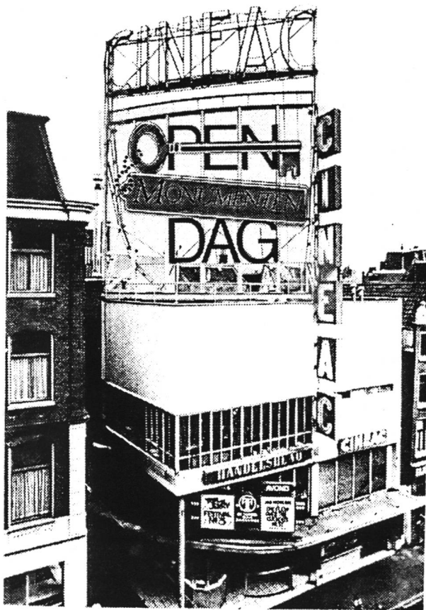
J. Duiker, Amsterdam 1934, CINEAC avec le logo de la journée des portes ouvertes
