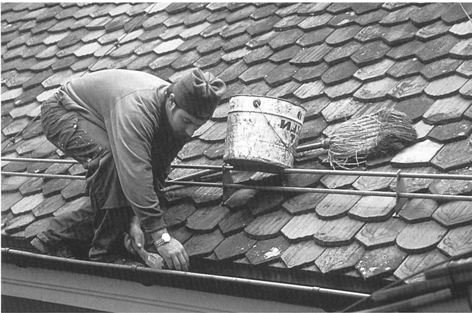
Kontinuierlicher Unterhalt: periodische Kontrolle des Daches, hier in der Berner Altstadt
