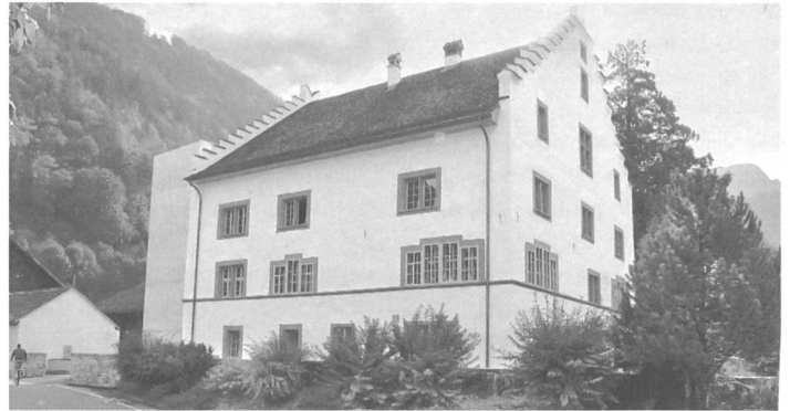
Suworow-Haus: Respektvoller Umgang mit der originalen Bausubstanz.
