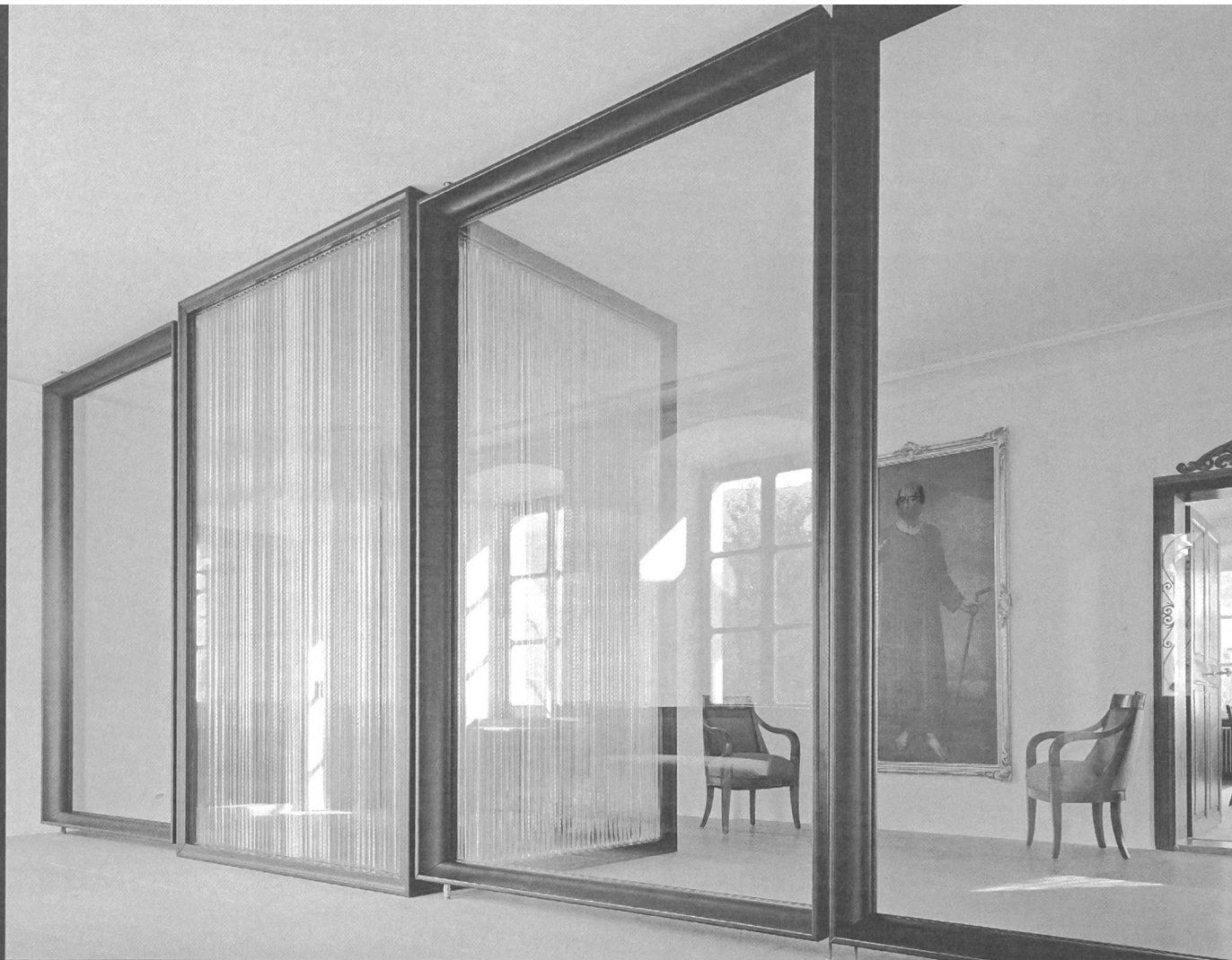
Die neuen Sicherheitsabschlüsse und die Liftschachtverkleidung in lederbezogenen Holzrahmen in der Eingangshalle des 1. Obergeschosses. Im Hintergrund der Regierungsratssaal.
