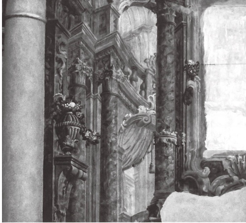
2. Locarno, chiesa di San Francesco, navata nord, particolare.
