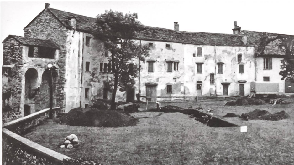
Bellinzona, Castelgrande: cour et bâtiments avant rénovation.
