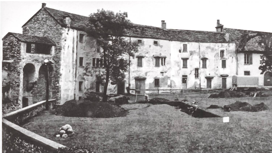
Bellinzona, Castelgrande: cour et bâtiments avant rénovation.
