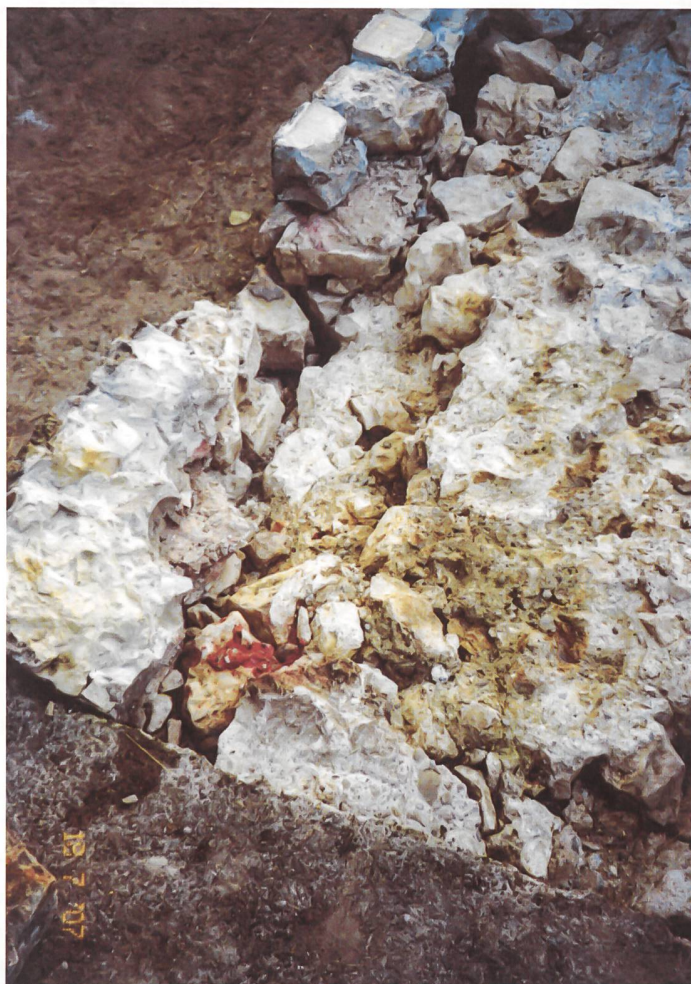
Vindonissa/Windisch (AG), Amphitheater. Zwei Schichten des originalen Mauerwerks. Links und unten rekonstruierte Mauerteile.
