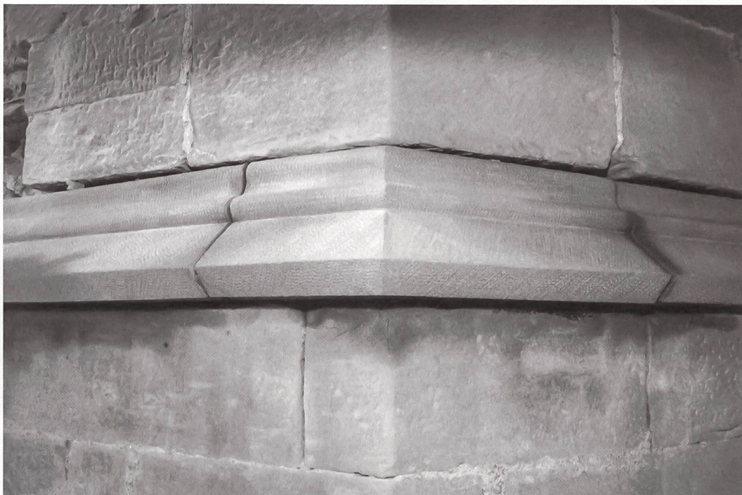
Ein komplett ersetztes Gurtgesimse, nachbearbeitet mit einem gezahnten Beil.
