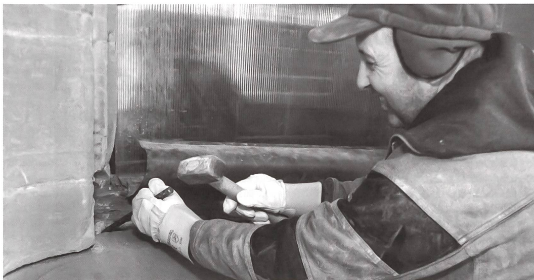
Eine neue Sohlbank aus dem Steinbruch bei Villarod wird unter das Gewände eines Fensters eingepasst.
