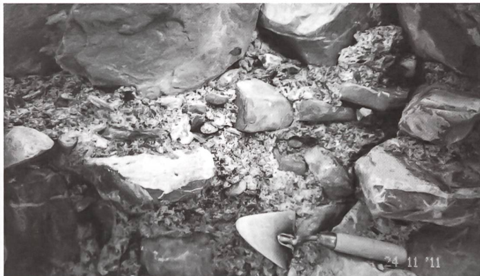
Attinghausen (UR), Burgturm. Blick in das Kernmauerwerk.
