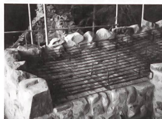
Lieli (LU), Burgturm. Armierung der rinnenförmigen Betonplatte mit Verankerung der Mauermäntel.
