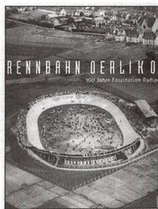
Mit der weltweit ersten Spannbetonkonstruktion war sie damals ein architektonisches Meisterwerk. Die Bahn hat eine Länge von 333 Metern und eine Kurvenneigung von 44,5 Grad. Sie hat in den vergangenen 100 Jahren eine wechselvolle Geschichte erlebt, das ständige Auf und Ab zeigt sich im häufigen Besitzerwechsel. Seit 2003 ist der Rennbetrieb in den Händen der IGOR (Interessengemeinschaft offene Rennbahn).
