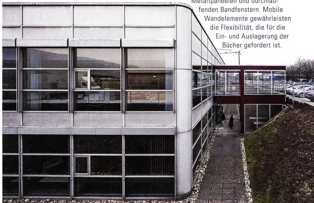
Schweizer Buchzentrum Hägendorf, 1973–1975 von Alfons Barth & Hans Zaugg: Das Stahlskelett über dem quadratischen Grundriss basiert auf einem durchgehenden Rastermodul von 7,2 Metern. Die vorgehängten Fassaden zeigen ein gleichmässiges Gitterbild aus silbergrauen Metallpaneelen und durchlaufenden Bandfenstern. Mobile Wandelemente gewährleisten die Flexibilität, die für die Ein- und Auslagerung der Bücher gefordert ist.
