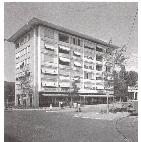
Das Locher-Haus, historische Aufnahme von 1956 und renoviert 2009.
