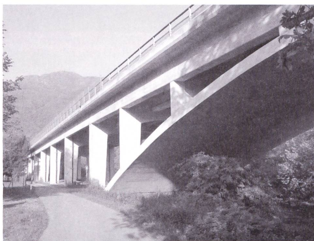
Fig. 6: Torricella-Taverne e Ponte Capriasca, Viadotto (1952), Walter Georg Krüsi (1890–1969).
