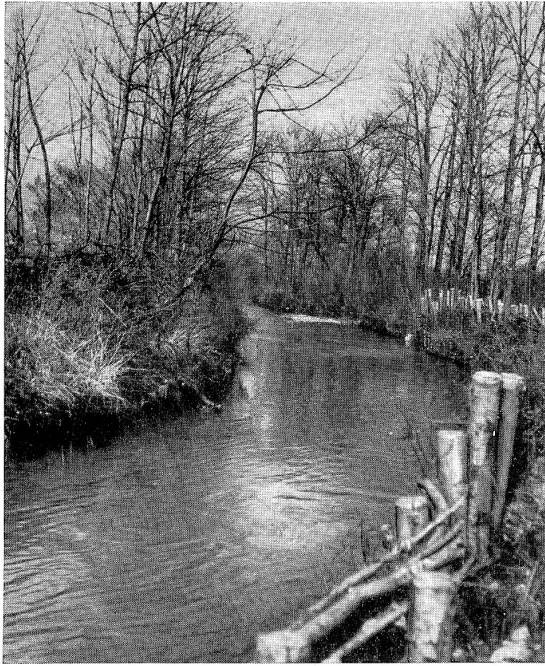
Abb. 12 Alte Dünnern zwischen Oensingen und Oberbuchsiten. Die stark erhöhten Uferdämme durch Pfahlwerk geschützt.
