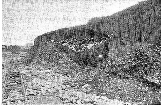
Abb. 17 Aushubschlitz östlich der Wangner Brücke.
