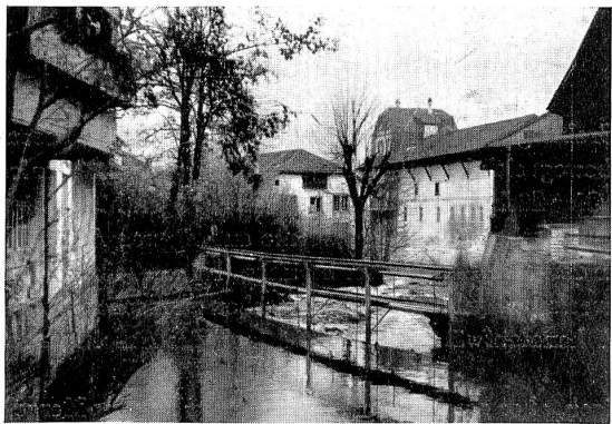
Abb. 19 Altes Stauwehr der Filztuchfabrik C. Munzinger & Cie. AG. Olten.
