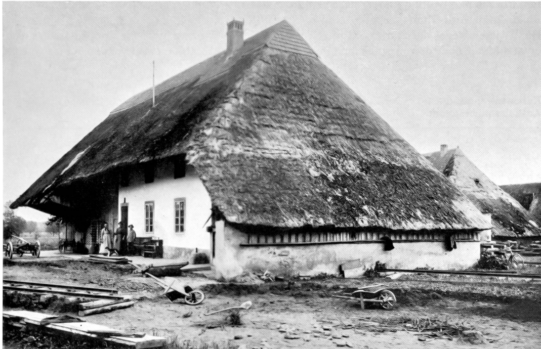
Haus mit Strohdach, das durch den Kanalbau abgebrochen werden musste.
