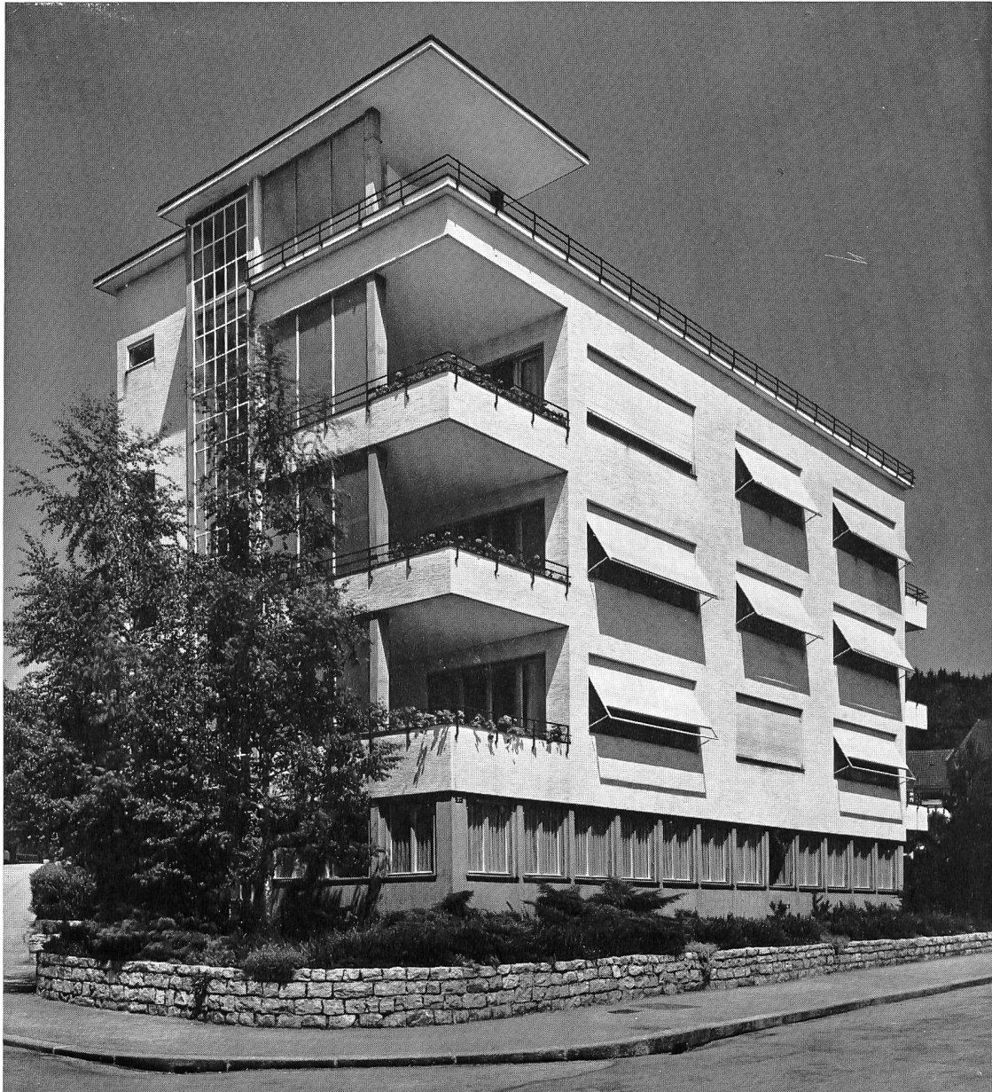
Frey und Schindler, Schweizerischer Samariterbund , 1938 Südwestseite. Verglaster Aufzugsschacht. Sichtbare Trennung zwischen Bürogeschoss und Wohngeschossen. Flachdach als Terrasse genutzt. Grosszügige Wohnbalkone.
