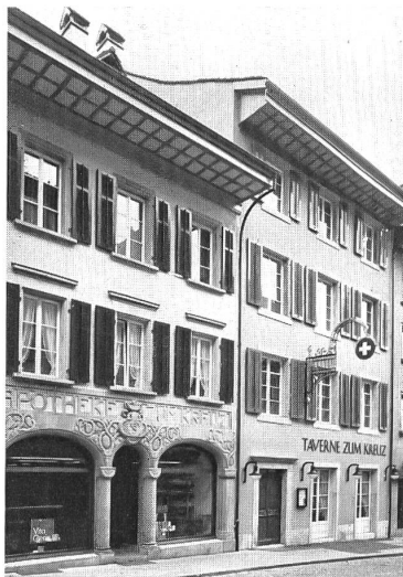
Hauptgasse nach Umbau 1978
