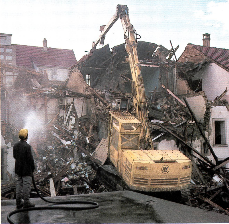
Abbrucharbeiten durch Bagger mit Spezialausleger.
