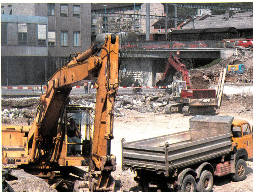
Aushubarbeiten, Überbauung Winkel, Olten.
