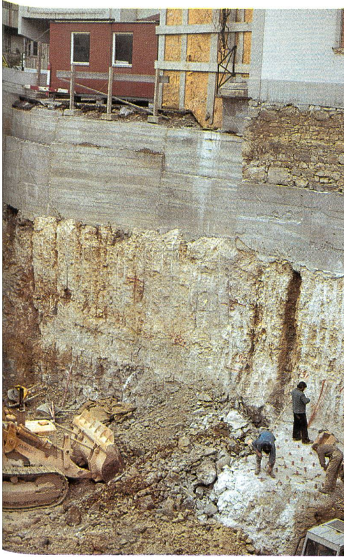
Felsaushub für Neubau in Olten.
