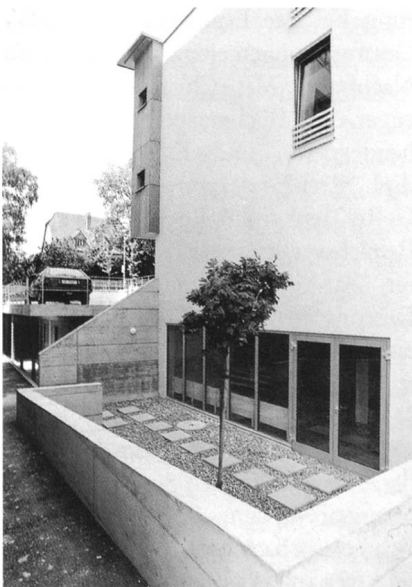
Büros über zwei Geschosse
