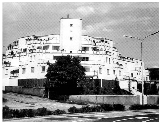
Oben: Alterswohnungen an der Aarauerstrasse
