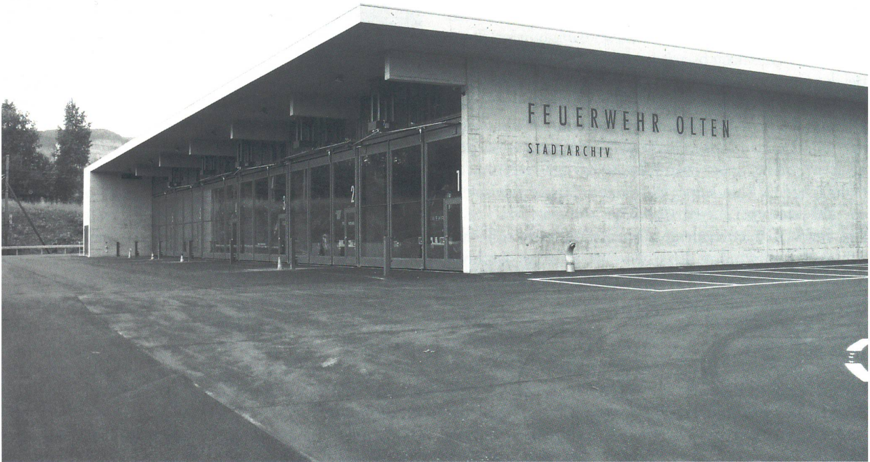
Im Untergeschoss des neuen Feuerwehrgebäudes befindet sich das Stadtarchiv heute.
