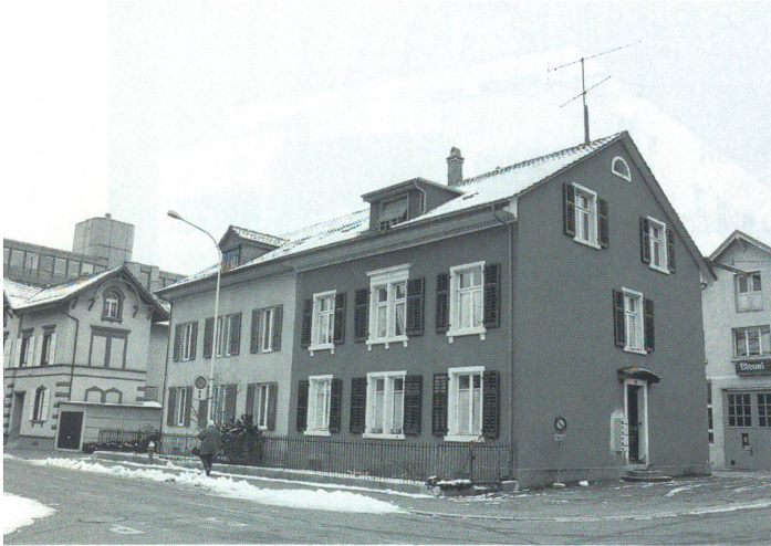
Die Situation vor dem Neubau der SIS an der Spitalstrasse
