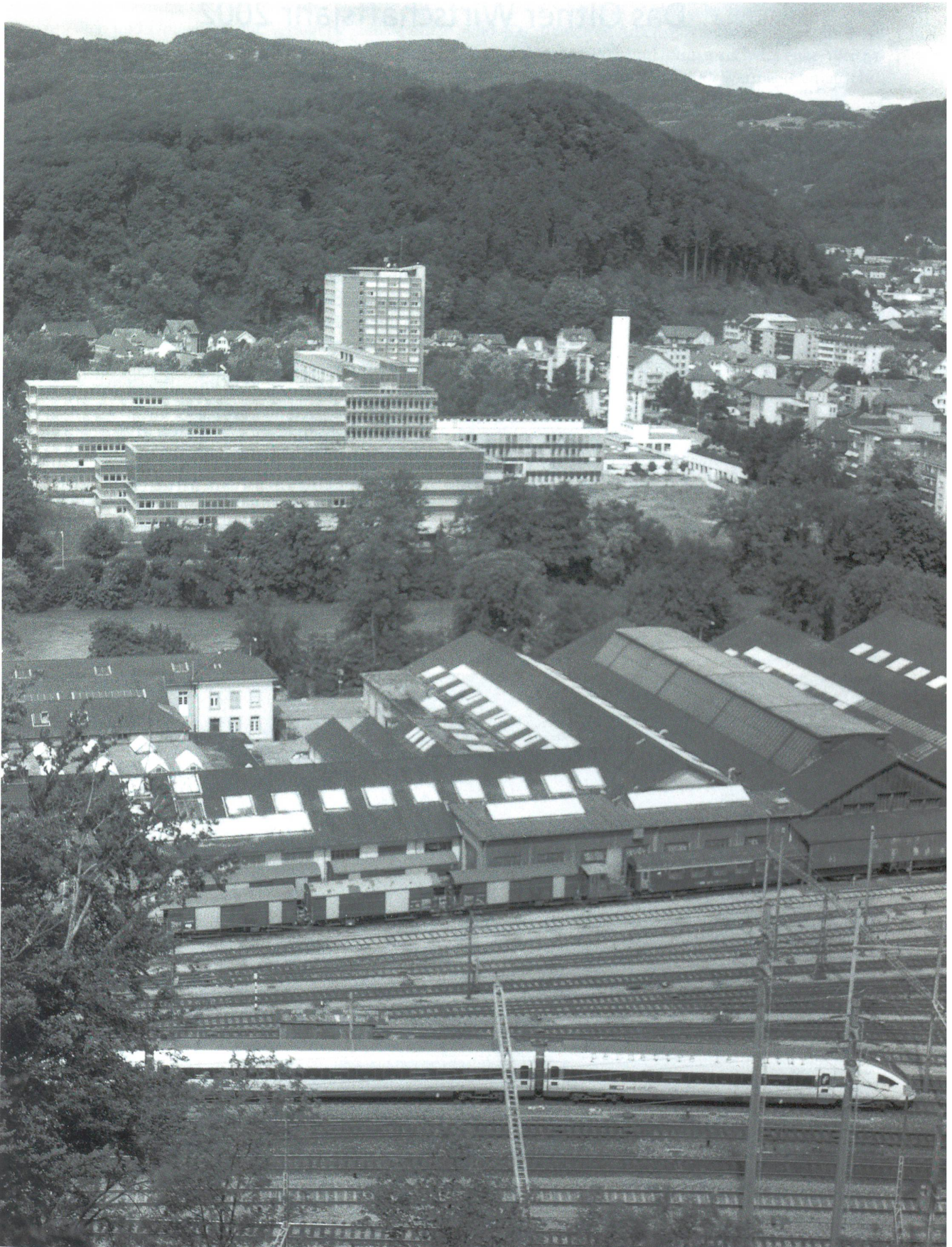
Die parallel zur Aare angeordneten grossen Volumina schaffen zusammen mit Jura, Aare und Bahn einen neuen urbanen Massstab.
