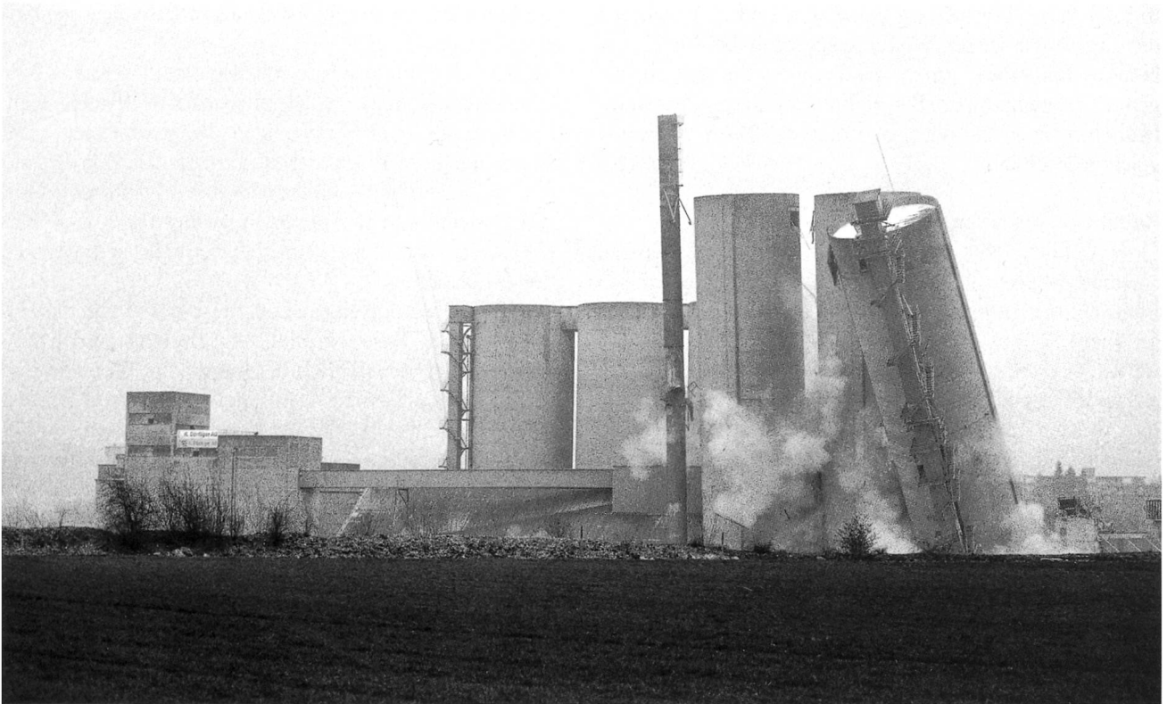
Die versuchte Sprengung der drei grossen Silos in der «Cementi»
