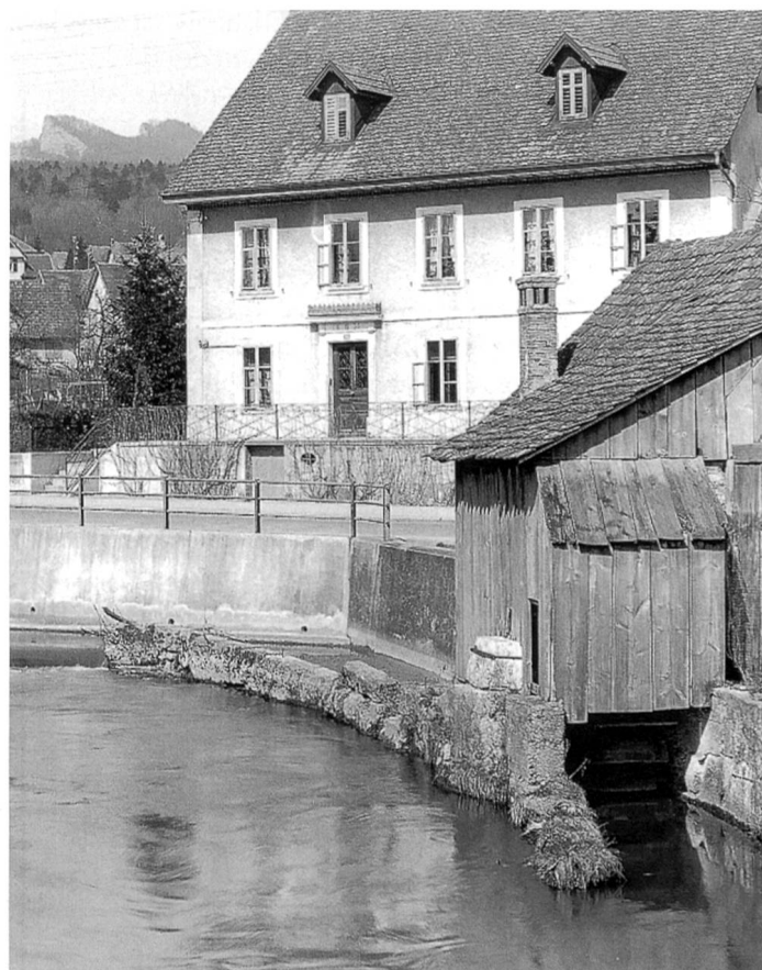
Wie diese Aufnahme schön zeigt, wurde die innere Bleickewalke im Hammer ebenfalls durch ein unterschlächtiges Wasserrad angetrieben.
