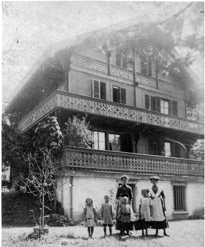
Chalet Riggenbach, Gartenseite
