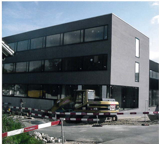
Neubau Riggbach AG auf dem Gelände des ehemaligen Schlachthofs
