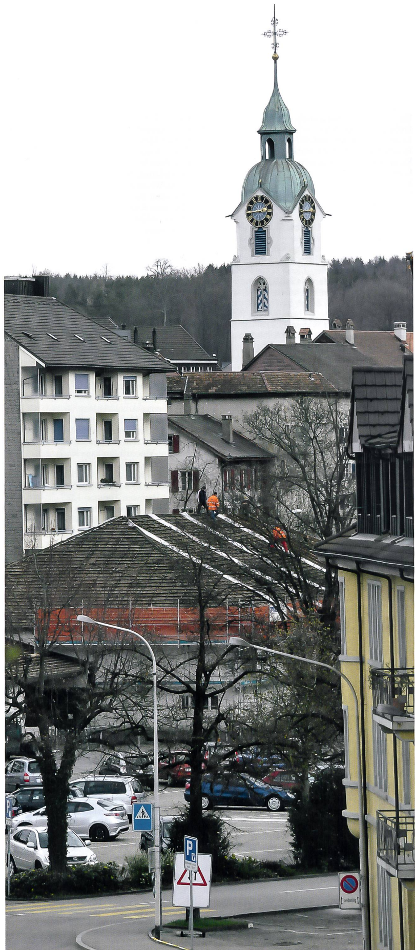
Beginn des Abbruchs der alten Reithalle auf der Schützenmatte
