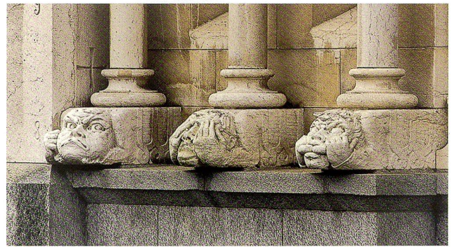
Sockel beim Hauptportal mit den sieben Hauptsünden, hier des Zornes, der Unkeuschheit und der Unmässigkeit
