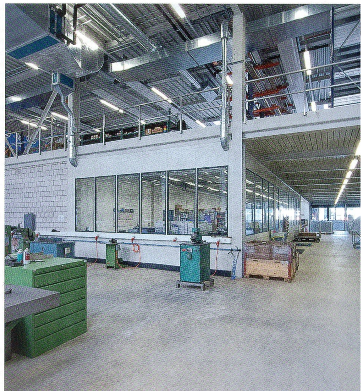
Produktionshalle, Bereich Kanalfertigung
