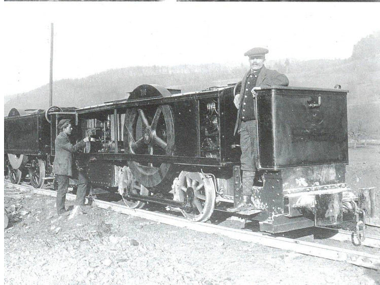
1 Löffelbagger vor dem bereits vollendeten Tunnel-Nordportal in Tecknau, Herbst 1912. 2 Das Tunnel-Nordportal in Tecknau ist vollendet. 3 Arbeiten beim Aushub des Staffeleinschnitts in Gelterkinden, 1913. 4 Benzinbetriebene Lokomotive, wie sie auf der Tunnelbaustelle Nord zum Einsatz kam. 5 Vor dem vollendeten Südportal in Tripolis, 1914. 6 Durchschlag im Sohlstollen am 10. Juli 1914. 7 Schalungsring (Lehrtrommel) für die Ausbetonierung des Schachtes. 8 Besichtigung beim Südportal Tripolis. Bekannte Personen: 3. von links Julius Berger, 4. von links Ingenieur E. Wiesmann, 5. von links Bauleiter Fritz Kolberg.
