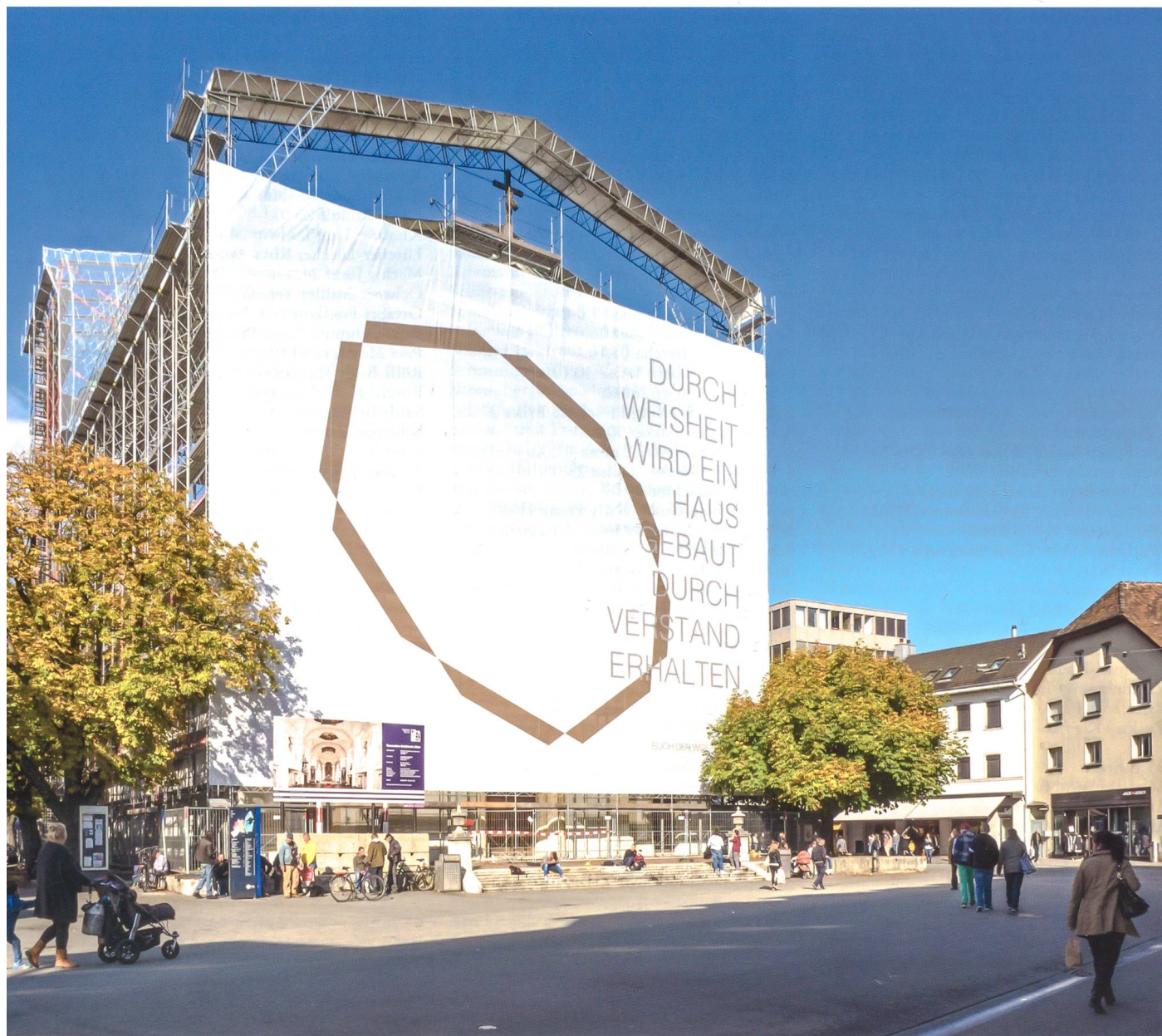
Die Stadtkirche eingerüstet zur Renovation
