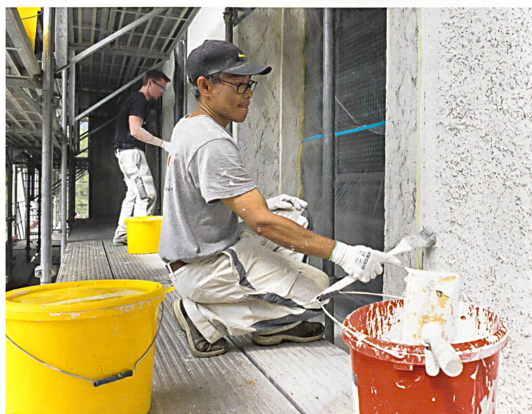
Oben: Ambrosius Warmbrodt bessert den Bogen eines Fensters im westseitigen Turm aus. Unten: Die Fassade erhielt nach einer gründlichen Reinigung einen dreifachen Anstrich mit Mineralfarbe.
