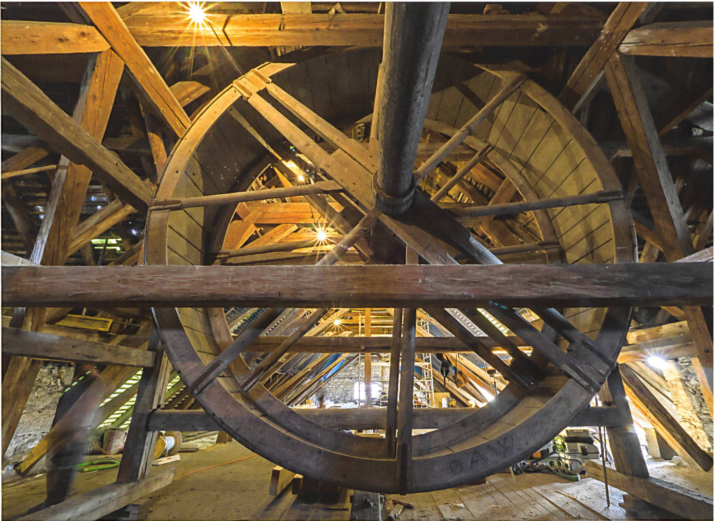
Das rund fünf Meter messende Tretrad auf dem Estrich der Stadtkirche, welches während des Baus als Hebekran diente
