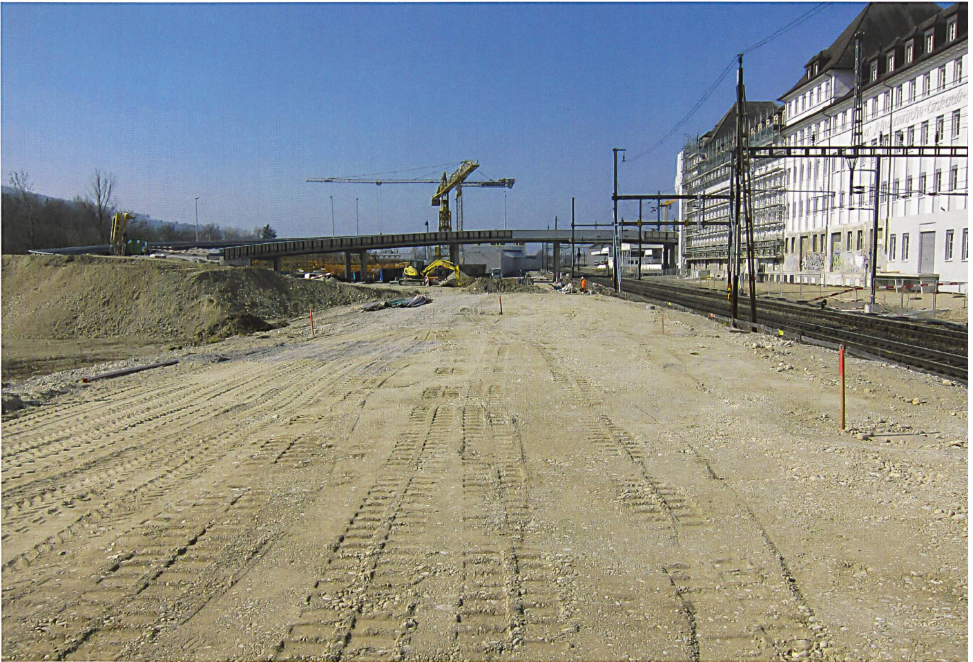
Trasse im Rohbau für das Projekt ERO, Olten
