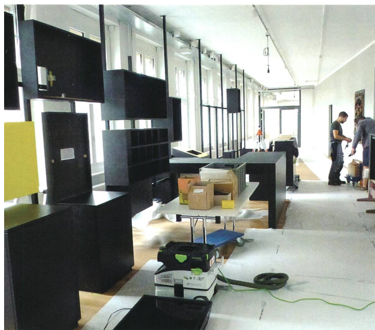
Oben: Ein erstes Modell wird erstellt. Unten: Impressionen der Aufbauarbeiten
