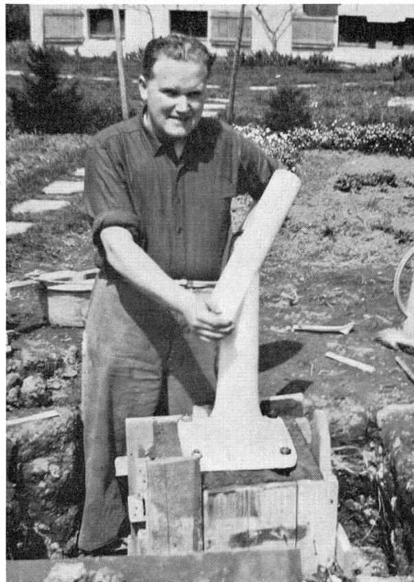
Abb. 1: Der Autor beim Einbetonieren des Stativfusses am 5. 5. 1956.
