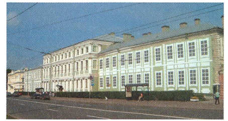
Fig. 13: Das Universitätsgebäude. Man beachte, dass die Fassade des rechten Flügels noch nicht restauriert werden konnte und daher mit einem bemalten Tuch verdeckt wurde. (Bild: A. VERDUN)
