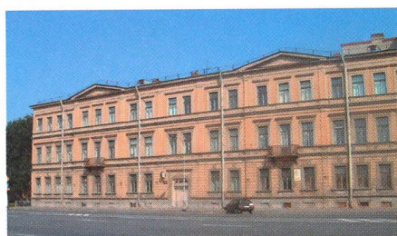
Fig. 7: Das Haus LEONHARD EULERS am Leutnant-Smidt-Kai 15, das er zwischen 1766 und 1783 bewohnte. Das dritte Stockwerk wurde erst im 19. Jahrhundert gebaut. (Bild: A. VERDUN)
