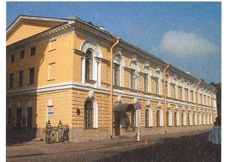
Fig. 14: Das Bibliotheksgebäude der Akademie der Wissenschaften. Obwohl das Äußere sehr schön restauriert wurde, sind die Verhältnisse im Innern des Gebäudes immer noch katastrophal. (Bild: A. VERDUN)
