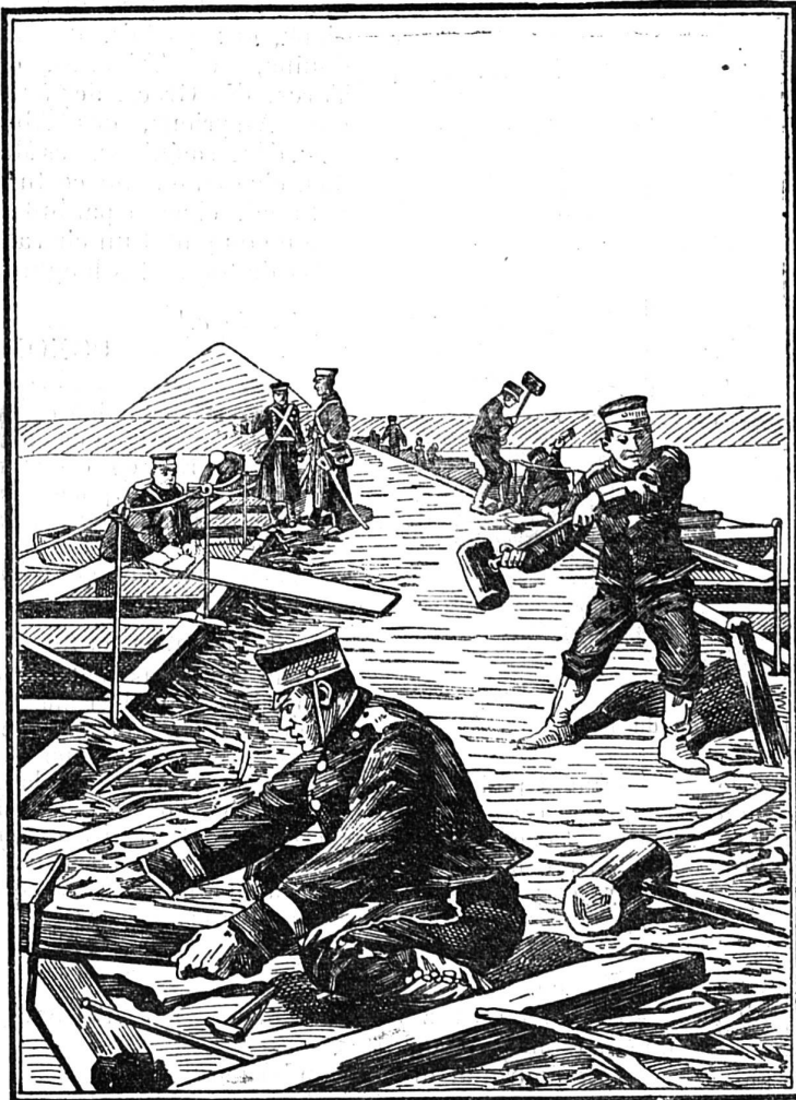
Pontonniers japonais construisant un pont.
