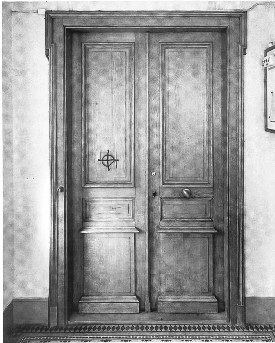
7 Porte d'entrée au rez-de-chaussée
