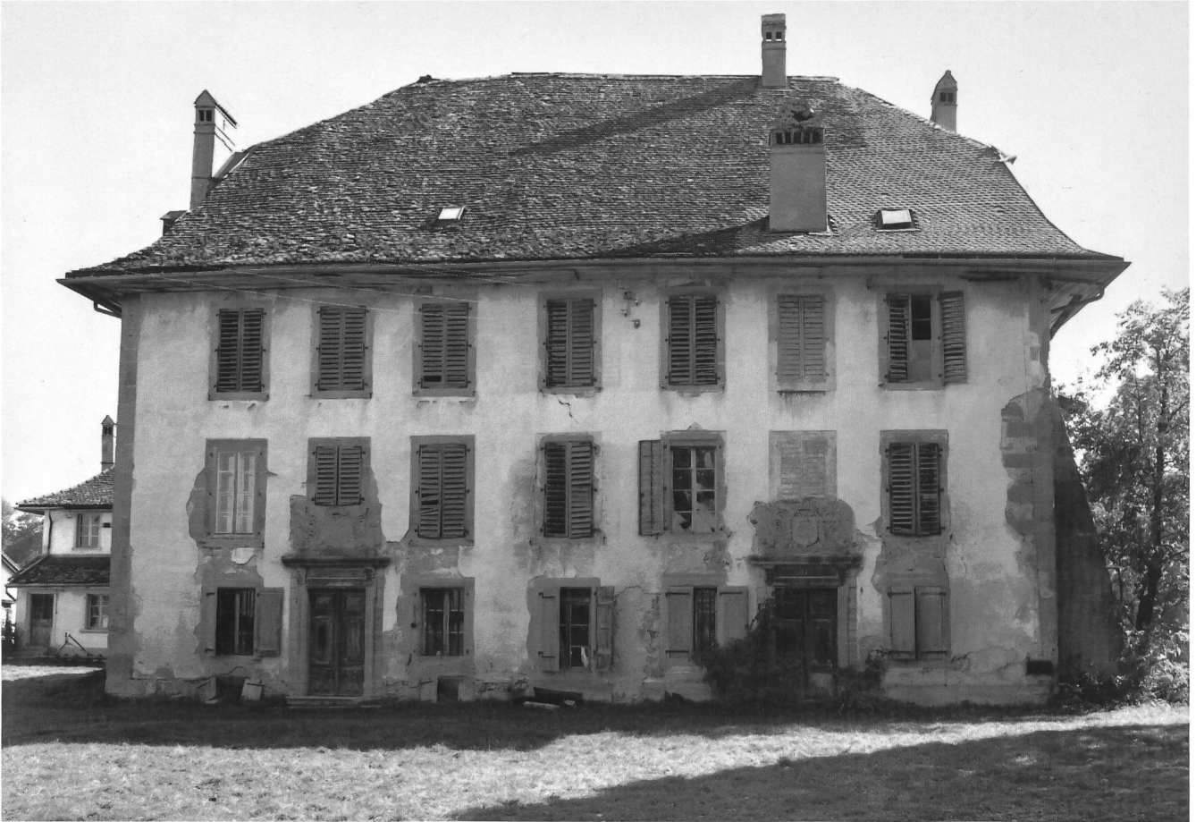
Fig. 13 Façade principale du château au nord-ouest, état en 1989.
