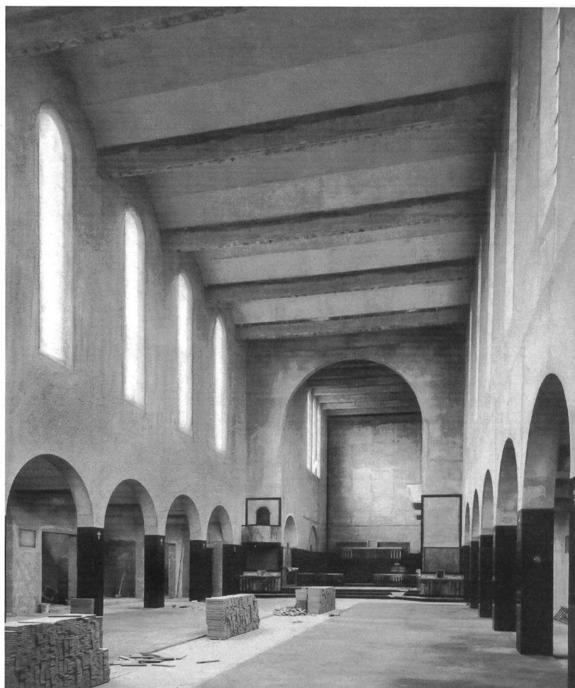
Fig. 16 Vue intérieure de l'église St-Pierre à Fribourg, en chantier, 1930.
