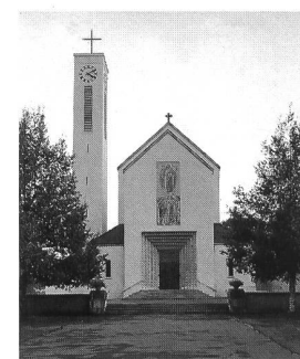
Fig. 31 Adolphe Guyonnet, Eglise du Christ-Roi à Tavannes BE, 1928-30.
