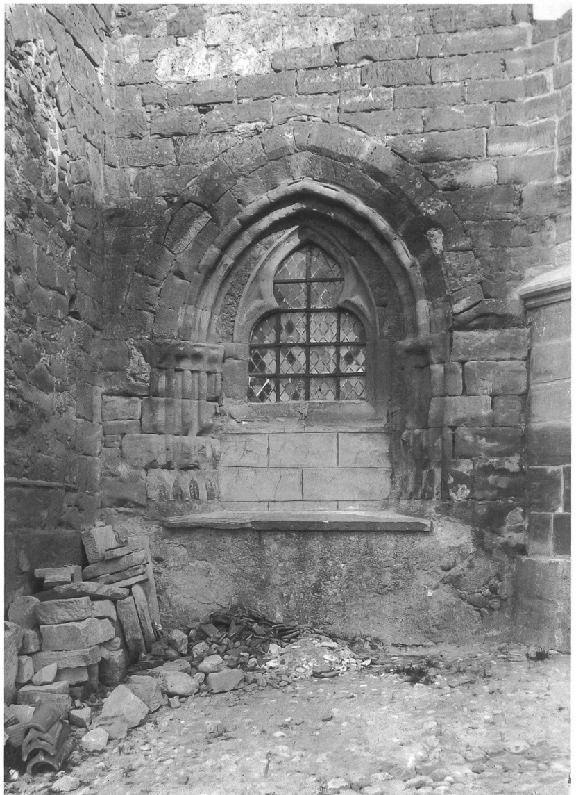
Fig. 8 L'entrée nord de l'ancien passage piétonnier à travers l'avant-nef, 1318-1330, état en 1912. Ce passage a été condamné après 1516 et une fenêtre ménagée à la place du tympan. Vers 1940, elle fut agrandie pour installer le vitrail de l'Assomption.
