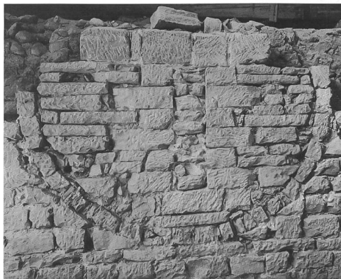
Fig. 9 Vestiges de l'oculus qui surmontait le portail de la façade de 1297, aujourd'hui portail intérieur de l'avant-nef. La photographie montre cette partie du mur avant sa démolition en 1939 lors de la pose de la soufflerie de l'orgue.
