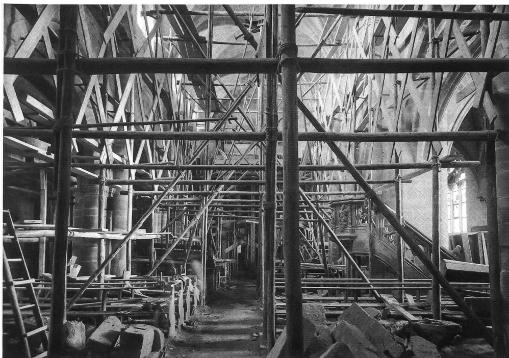
Fig. 75 Une forêt d'échafaudages, dans la nef, en 1938. La dimension des blocs de molasse, à terre, en dit long sur la conception de la restauration menée par Fernand Dumas.
