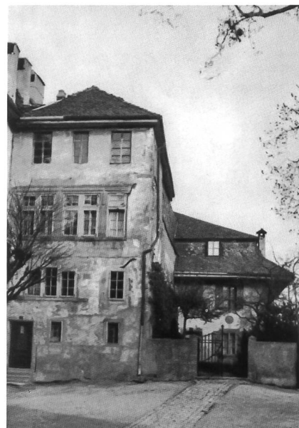
Fig. 110 La curette (maison Musy-Malliard) et la cure de 1734, transformée en 1844 par les architectes Johann Jakob Weibel et Hans Rychner de Fribourg, démolies en 1958. Avant la construction de la Maison de Ville, en 1540, c'est à la cure que le Conseil siégeait et qu'on gardait les archives de la ville. Ce bâtiment, propriété du clergé depuis 1405/1406, fut donc l'un des lieux de pouvoir de Romont.
