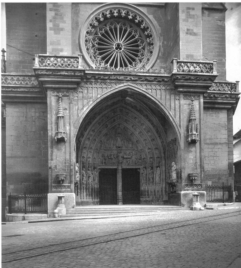
Fig. 7 La face extérieure du porche de St-Nicolas, vers 1943. – Conçu par Johann Jakob Weibel en 1844, l'aménagement néo-gothique d'excellente qualité est ici montré dans toute son ampleur, y compris les grilles en fonte fermant les angles des contreforts.
