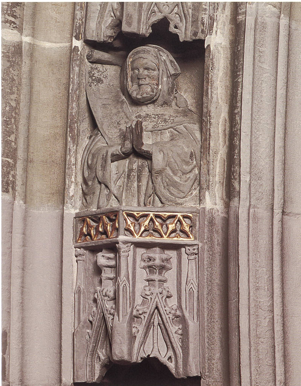
Abb. 62 Teil der zweiten Archivolte: Zustand nach dem Auftragen der schützenden Grau-Gold-Fassung in der unteren Hälfte.
